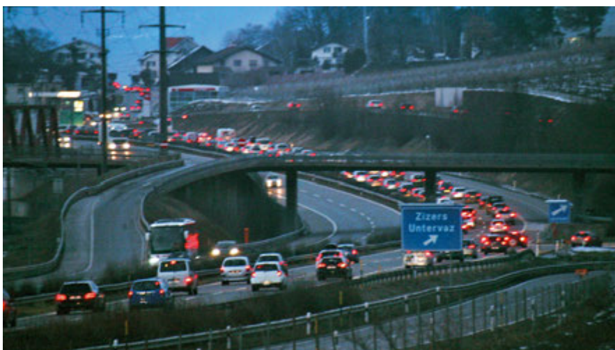
Düsteres Bild: Ohne ausreichenden Unterhalt am Strassenverkehrsnetz bleiben wir auch in Graubünden im Stau stecken.
