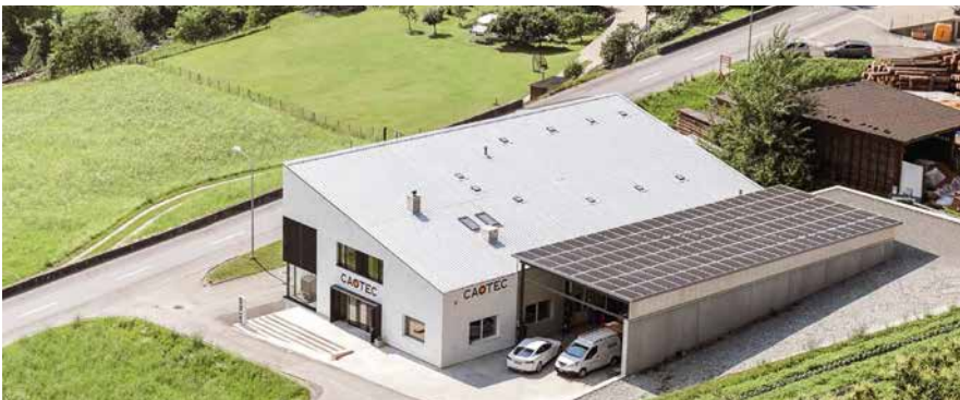
Das ausgezeichnete PlusEnergie-Gewerbegebäude von Caotec in Brusio. (Bild: zVg)
