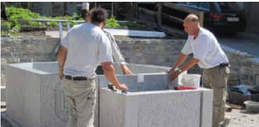
Dorfbrunnen, Lüen – Massivbauweise
