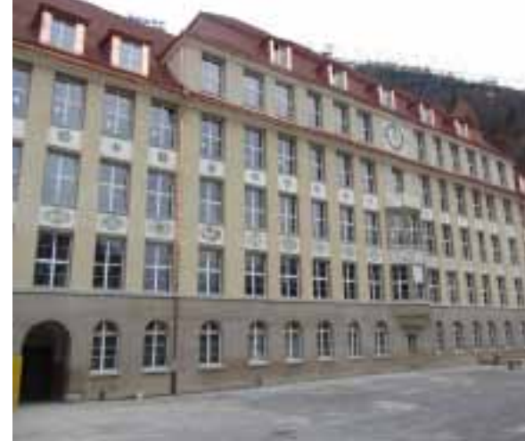
Quaderschulhaus, Chur – Fassadenrenovation
