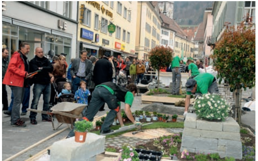
Die Natursteinmauer, die Pflasterung und das Holzbrückli sind fertig – jetzt gehts ums Begrünen.
