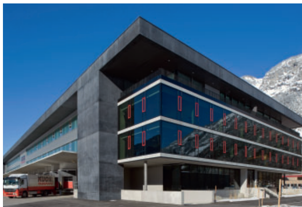
Das neue Umschlag- und Logistikzentrum der Gebr. Kuoni Transporte AG, als eines der grössten Gebäude im Kanton Graubünden, befindet sich neu in Domat/Ems.
